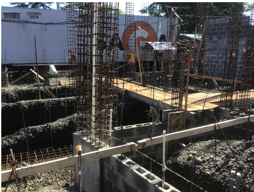
Ilustración 9 Rampa primer nivel
