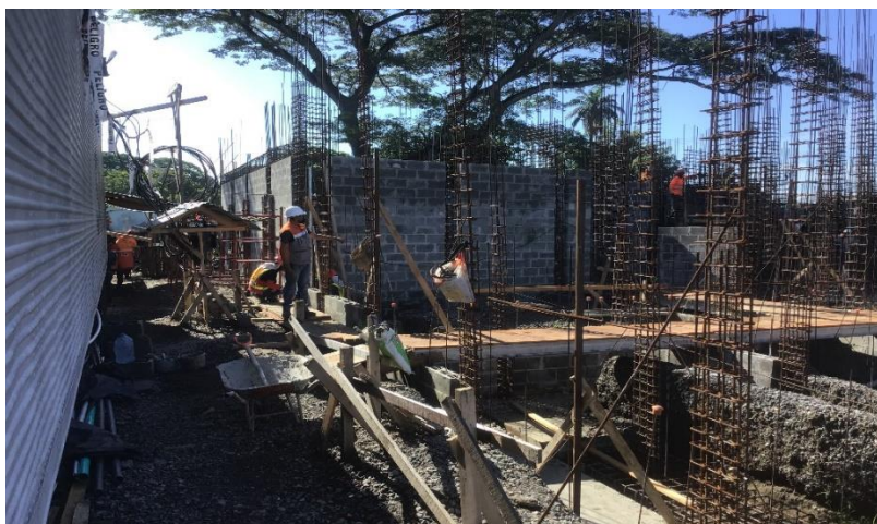
Ilustración 6 Paredes de mampostería del primer nivel
