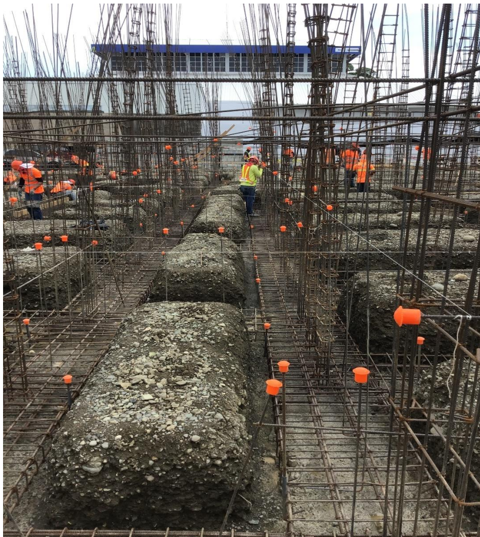
Ilustración 11 Cimentaciones edificio Administrativo
