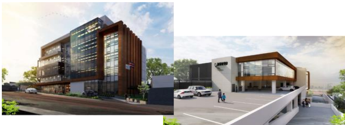
Ilustración 1 Vista general del proyecto Sede Central
