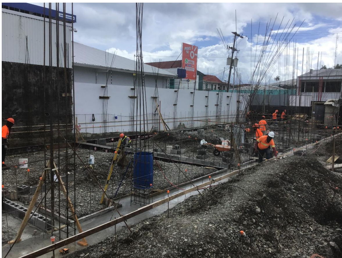
Ilustración 13 Placa edificio de Capacitaciones Bloque A
